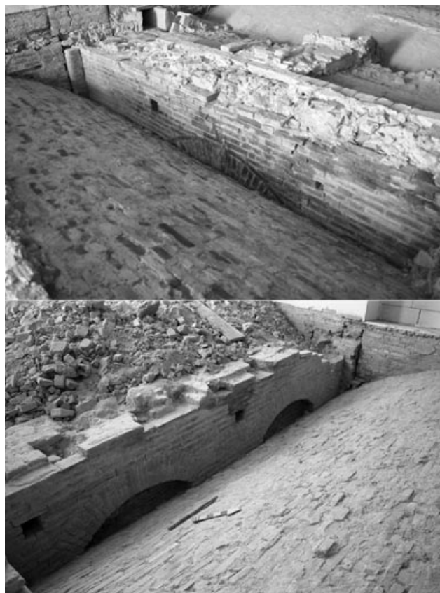
Fig. 3 – Corsia San Galgano, particolare dei muri perimetrali dell’abitazione di metà XIII secolo: in alto, la facciata; in basso, il retro della casa.
